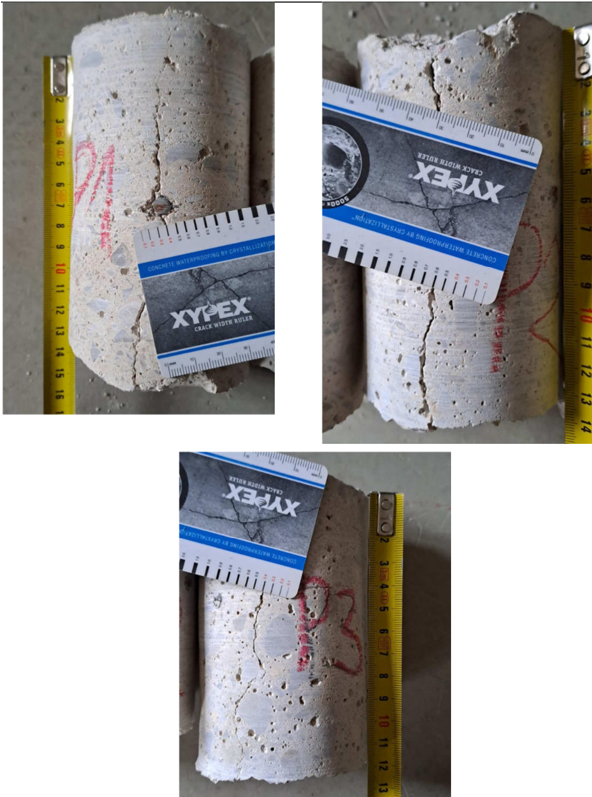
Слика 1 – Присуство прслина у бетону
