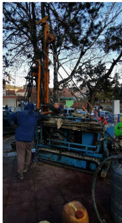
Слика 3. Извођење истражне бушотине ВU-1 (лево) и истражне бушотине ВU-2 (десно) током новембра 2022. на локацији дечијег базена у Ужицу.
