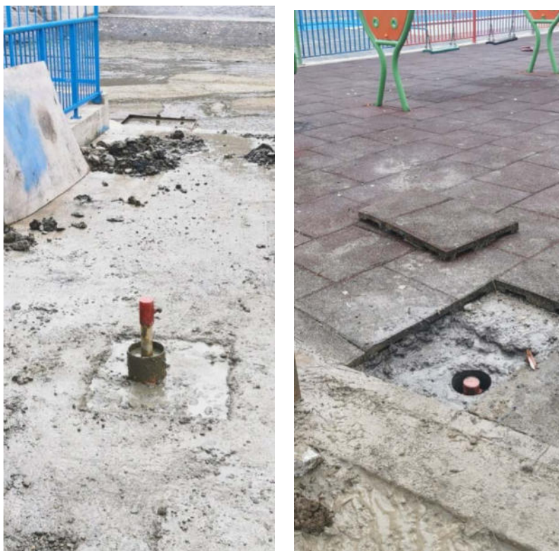
Слика 4. Инклинометарске конструкције BU-1 (лево) и BU-2 (десно) након уградње и заштите
