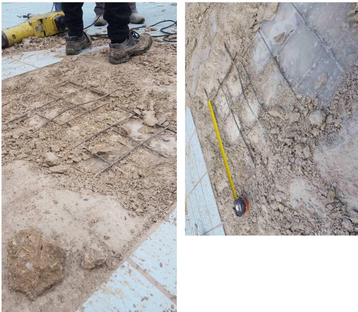
Слика 2 – Присутна арматура у горњој зони плоче
