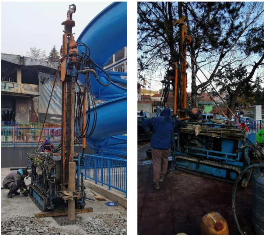
Слика 3. Извођење истражне бушотине ВU-1 (лево) и истражне бушотине ВU-2 (десно) током новембра 2022. на локацији дечијег базена у Ужицу.
