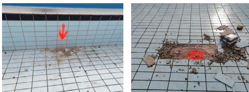
Слика 5.2. Позиције репера O4, O5 на објекту
