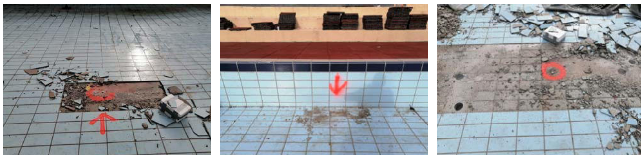
Слика 5.1. Позиције репера O1, O2, O3 на објекту
