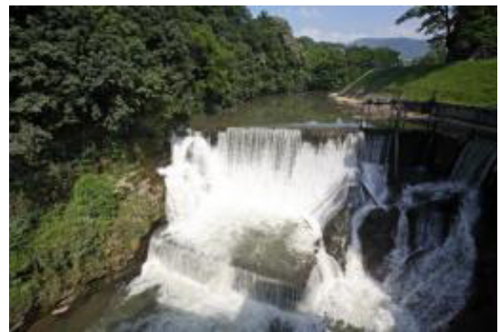
Слика 54- Електрична централа на Моравици. Извор: ТО Ивањица
