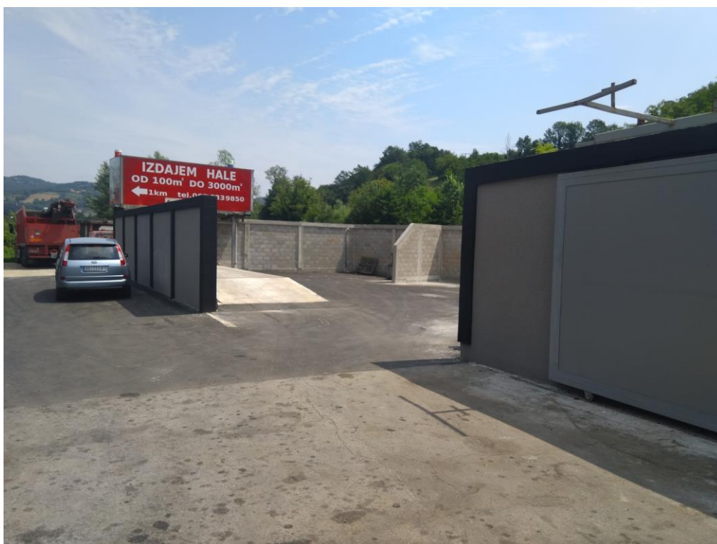
Слика бр. 3: Улазна капија у дограђени део складишта
