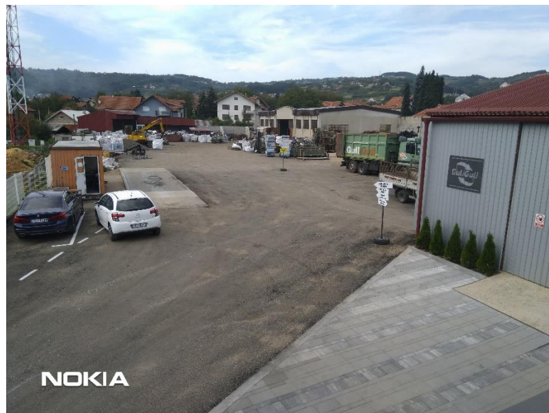
Слика 2. Комплекс постројења
