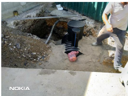
Слика 8. Уградња сепаратора
