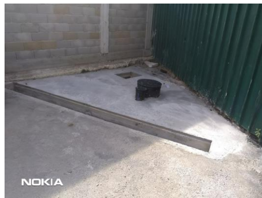
Слика 9. Таложна решетка, сепаратор и место узорковања
