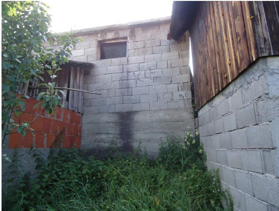
Slika 3.1 Pozicija na kojoj se planira instalacija RBS „KG3059_04 UE_Uzice_Vojvode_Bojovica“
