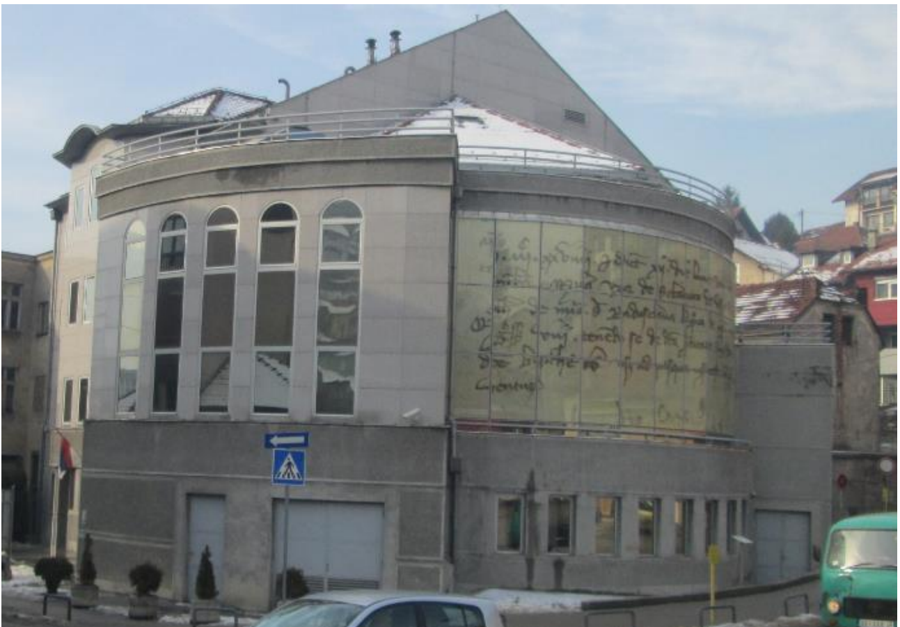
Slika 2.5 Predmetni objekat na kom se planira postavljanje bazne stanice
